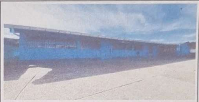
Foto 8: Pintado de pared de 3 aulas por afuera.
