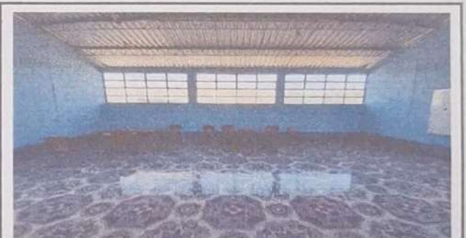
Foto 10: Pintado de pared de 3 aulas por adentro.
