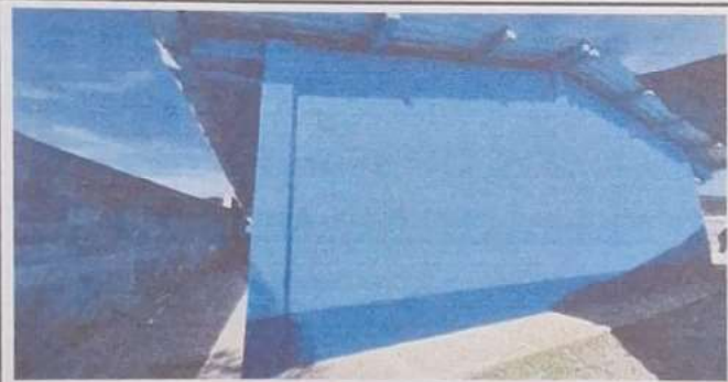
Foto 9: Pintado de pared de 3 aulas por afuera.
