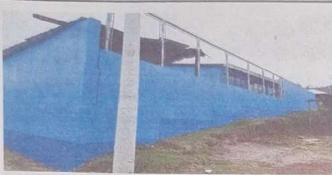
Foto 7: Pintado del muro exterior lado derecho del establecimiento.
